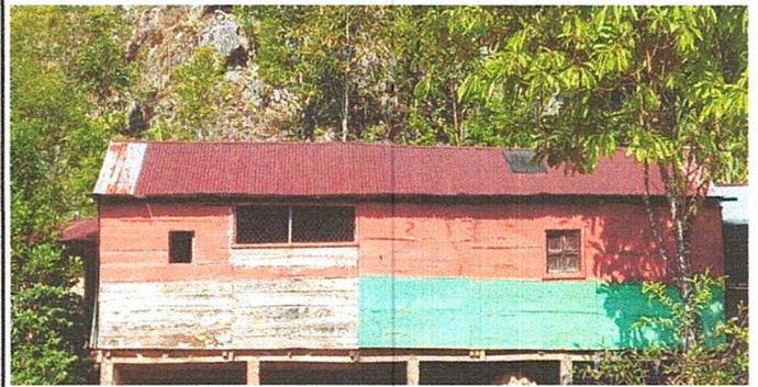
Foto 2: La cocina requiere reparación en toda su estructura
